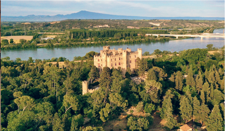
Blick auf Château de Montfaucon an der Rhône und den Mont Ventoux.
